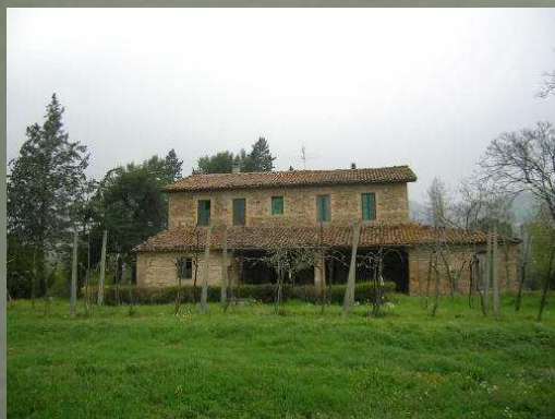
Casa padronale su 2 piani con struttura in pietra e mattoni con porticato e forno. Ubicato a Casinina (PU).
