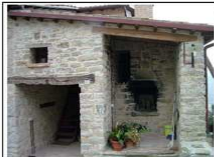
FOTO 1 Vista frontale del forno
