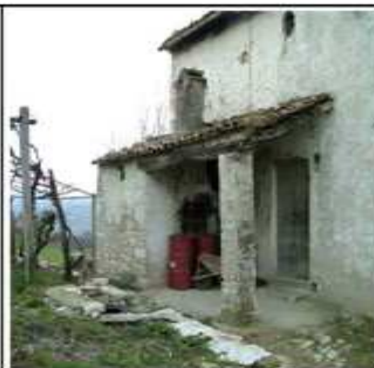
FOTO 2 Vista laterale del forno
