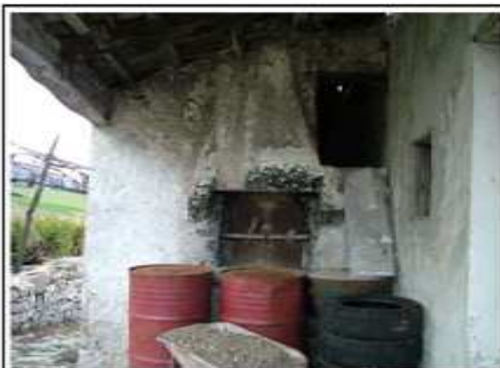
FOTO 1 Vista frontale del forno
