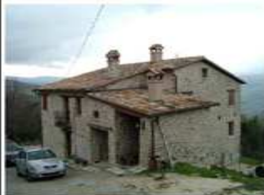
FOTO 2 Vista in diagonale del forno
