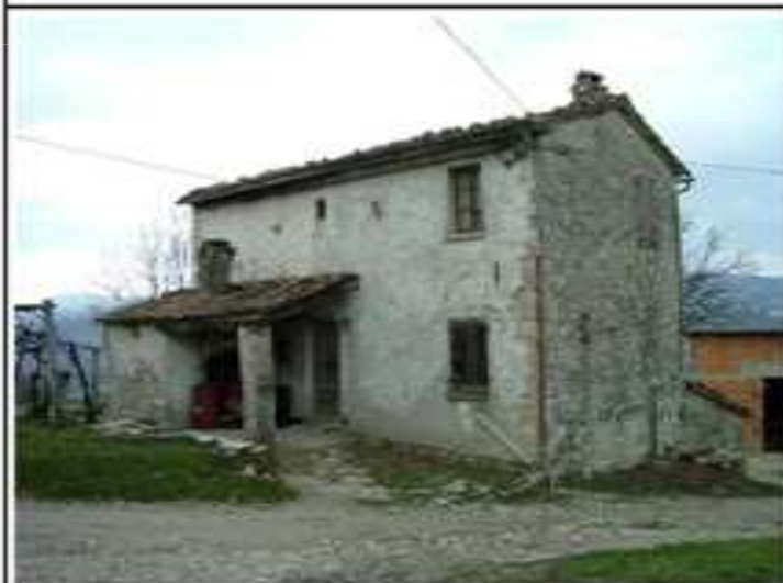
FOTO 3 Vista in diagonale del forno
